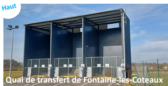
Transfert des OMr* et emballages
